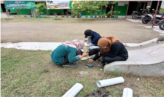
Gambar 5. Pembuatan Lubang Resapan Biopori (LRB)
